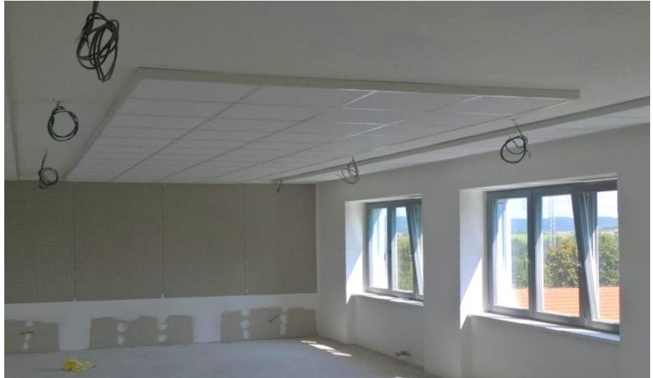
Rekonstrukce školního areálu.
