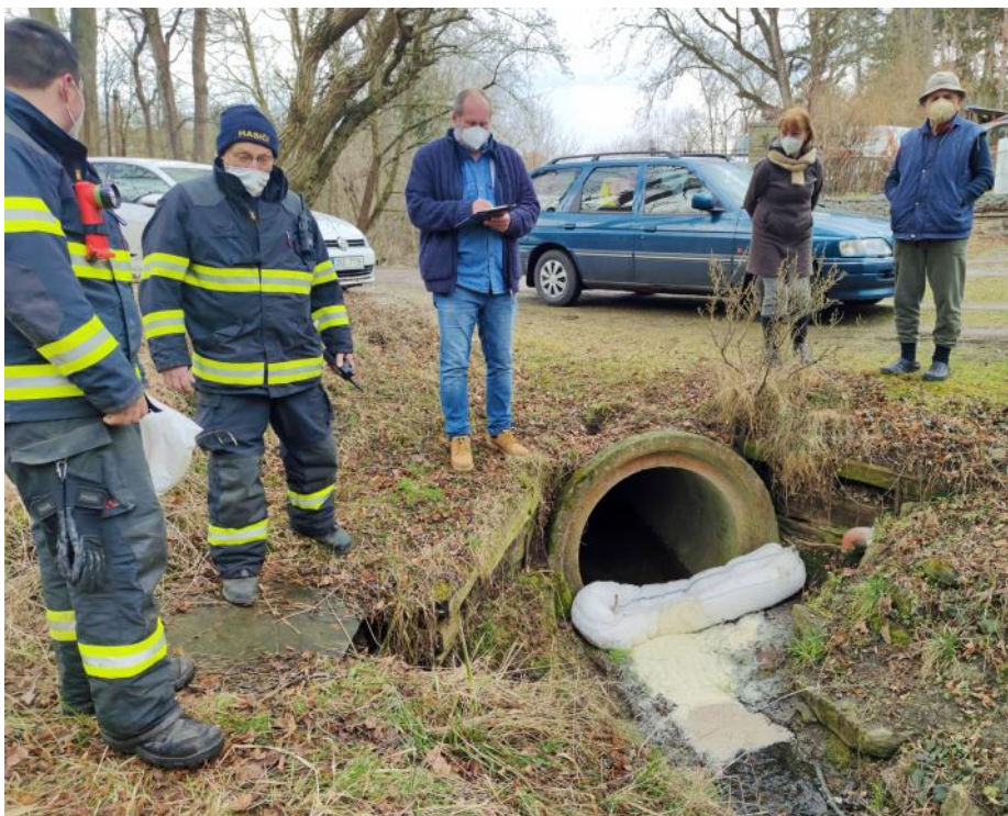
Zábrany na bělečském potoku proti šíření nafty. FOTO: Jiří Vodička
