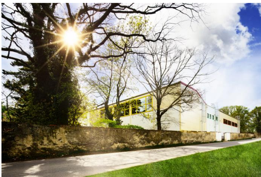
Opravená budova bývalého učiliště. FOTO: LLENTAB, spol. s r.o.
