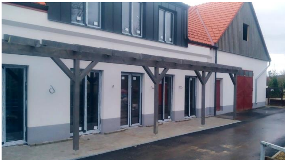
Komunitní centrum v Bělči již s fasádou, která mohla být dokončena díky oteplení mezi svátky. FOTO: Filip Kaštánek
