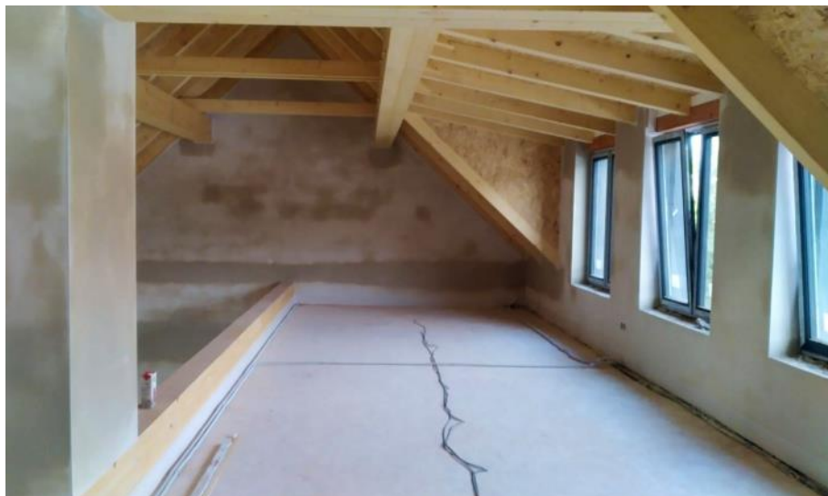
Stavební práce v Komunitním centru Běleč probíhají podle plánu, omítky uvnitř jsou hotové, stejně jako elektroizolace. FOTO: Filip Kaštánek
