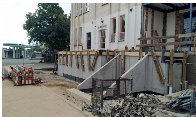
Usazování schodiště pomocí jeřábu.
