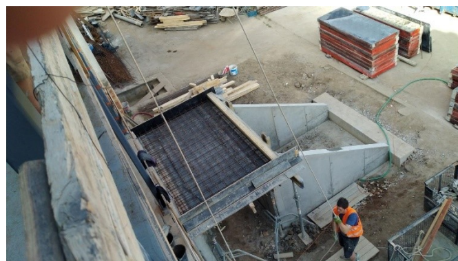
Usazování schodiště pomocí jeřábu.
