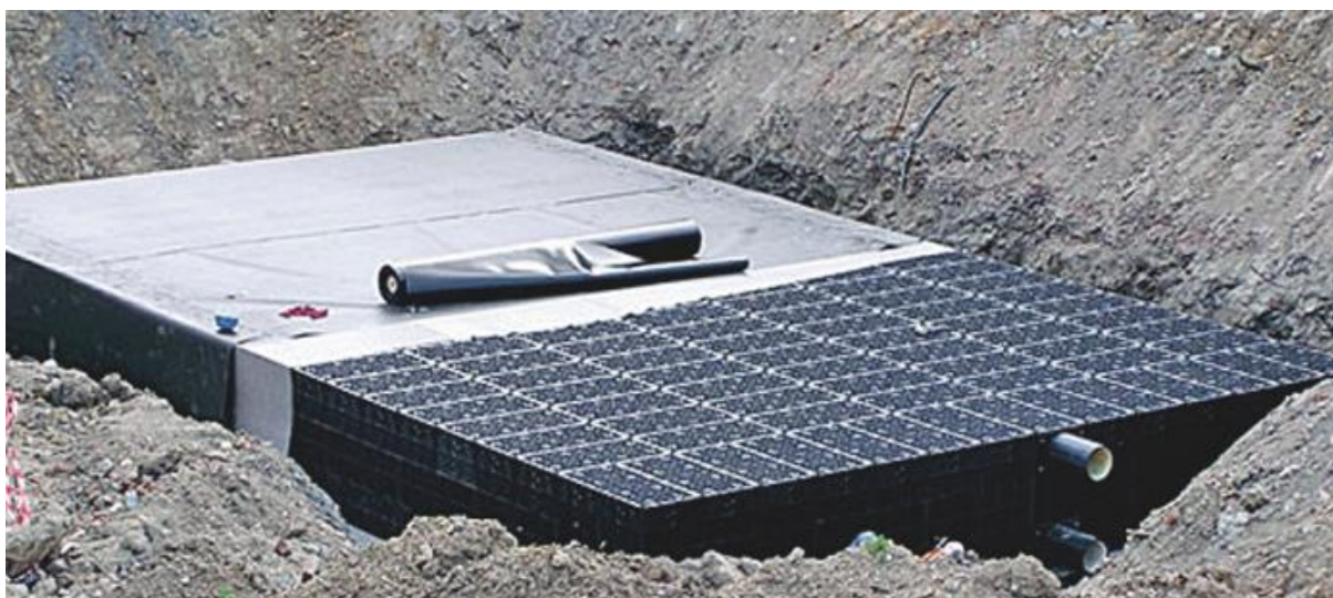
Obr. 5: Příklad vsakovacího zařízení
