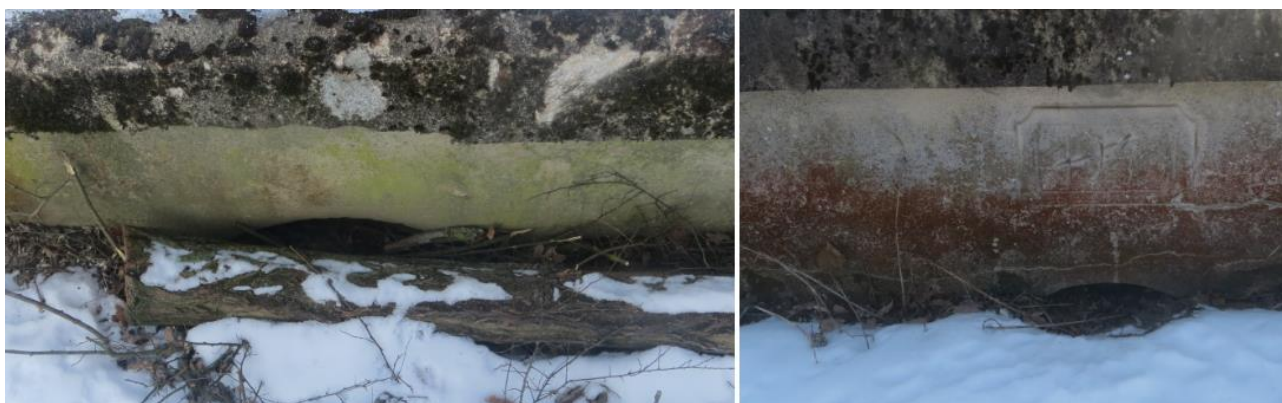
Obr. 4: Stávající stav propustku P3
