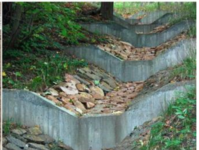
Zpevnění odvodňovacího příkopu
