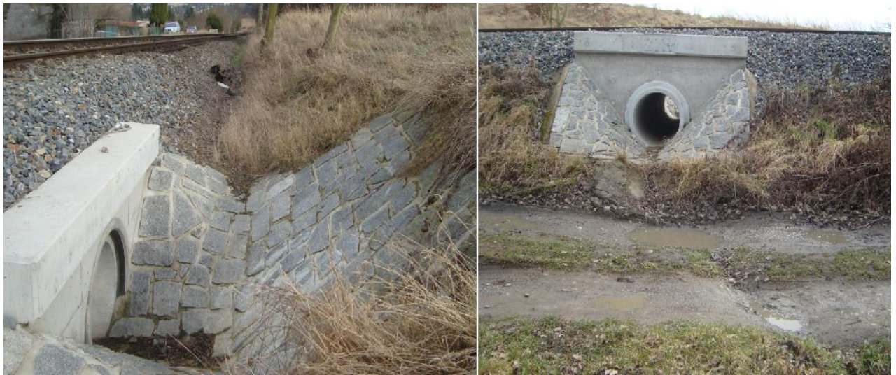
Obr. 8: Stávající železniční propustek P10
