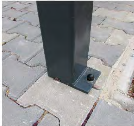
Kotvení konstrukce do bet. patky skrz zámkovou dlažbu: (ref. obr.)
