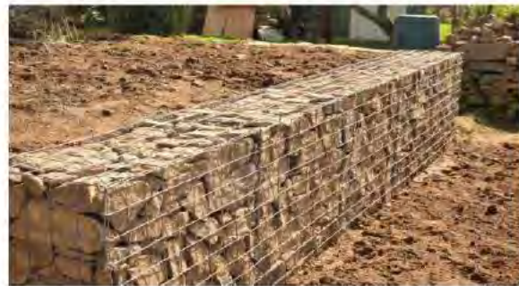
Opěrná zídka z gabionů, pro stanoviště č. 2 (ref. obr)
